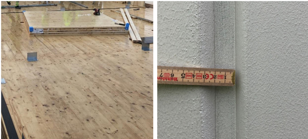
Figur 2: Illustration av de två fallstudierna. Vänster: Korslimmat trä i produktionsskede. Höger: Förkomprimerat fogband i betongsandwichfasad.
